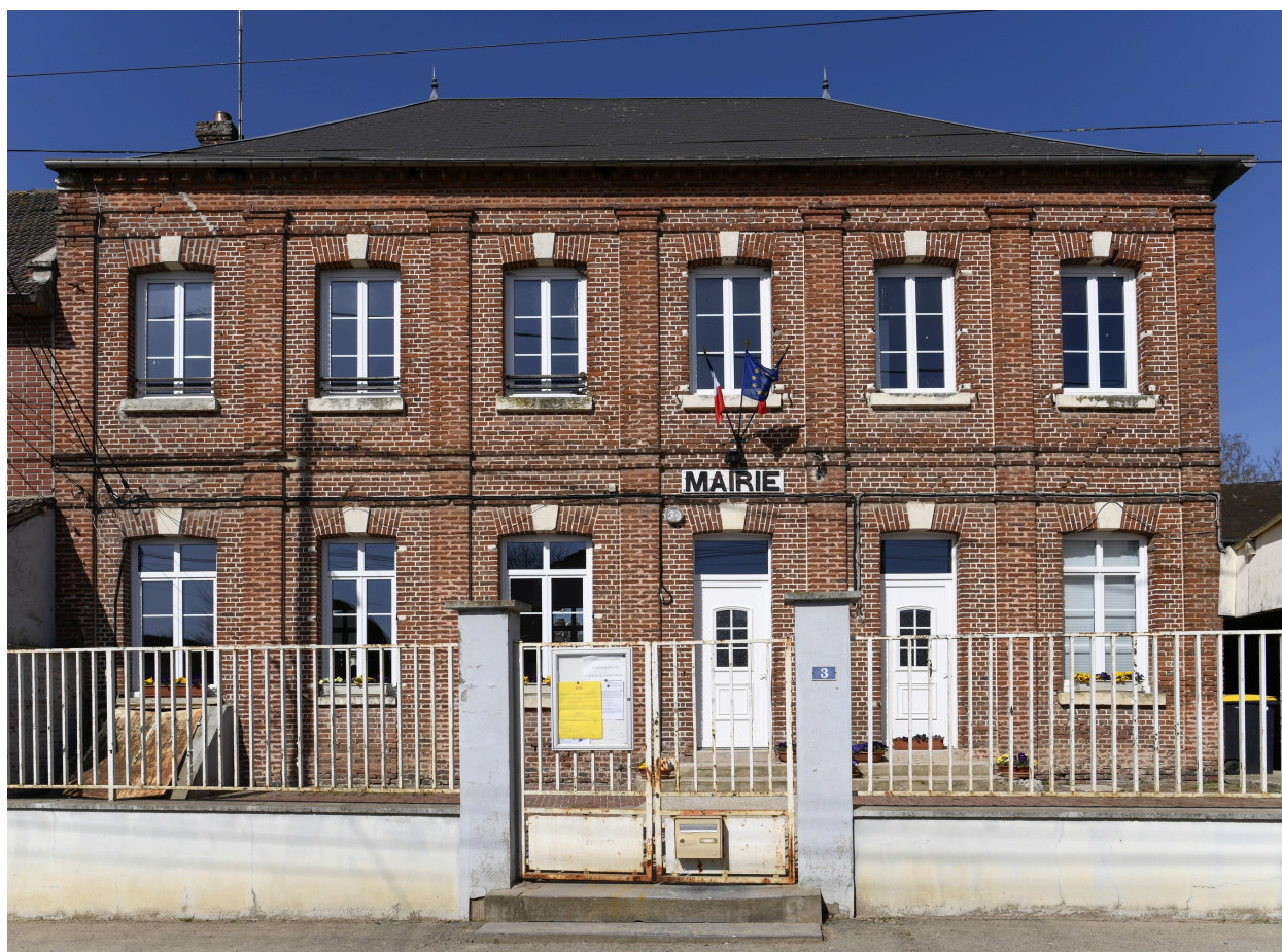
Mairie-école, rue de l'École, vue depuis l'est.
