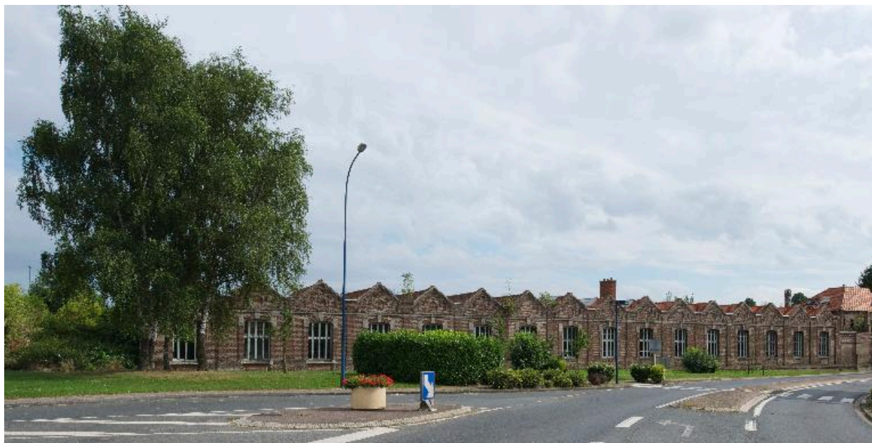
Vue d'ensemble sur rue des bâtiments administratifs de l'usine.
