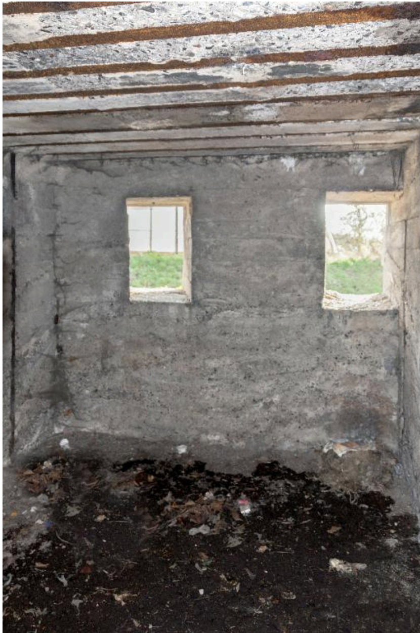
Casemate a. Vue interieure de la salle ouest, vers la rue
