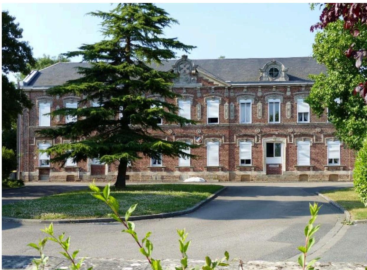
Vue de la façade sud.
