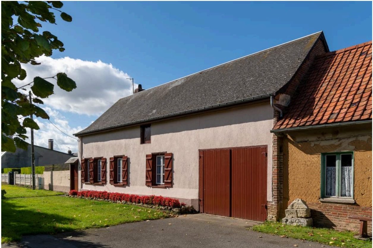
Logis sur rue, n°40 Grande Rue, vue depuis l'est.
