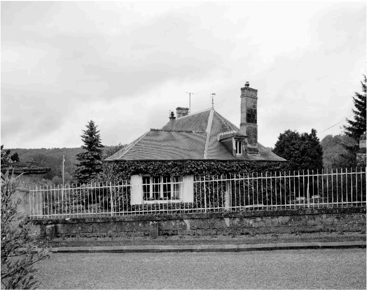
Vue de l'ancien presbytère, depuis la rue de l'Église à l'ouest.
