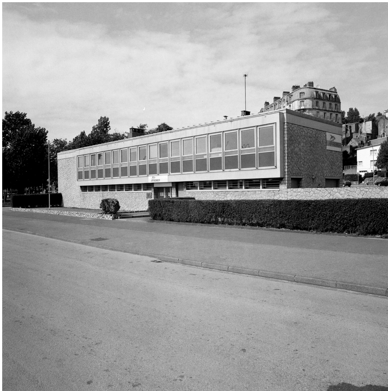
Laboratoire, façade sud.
