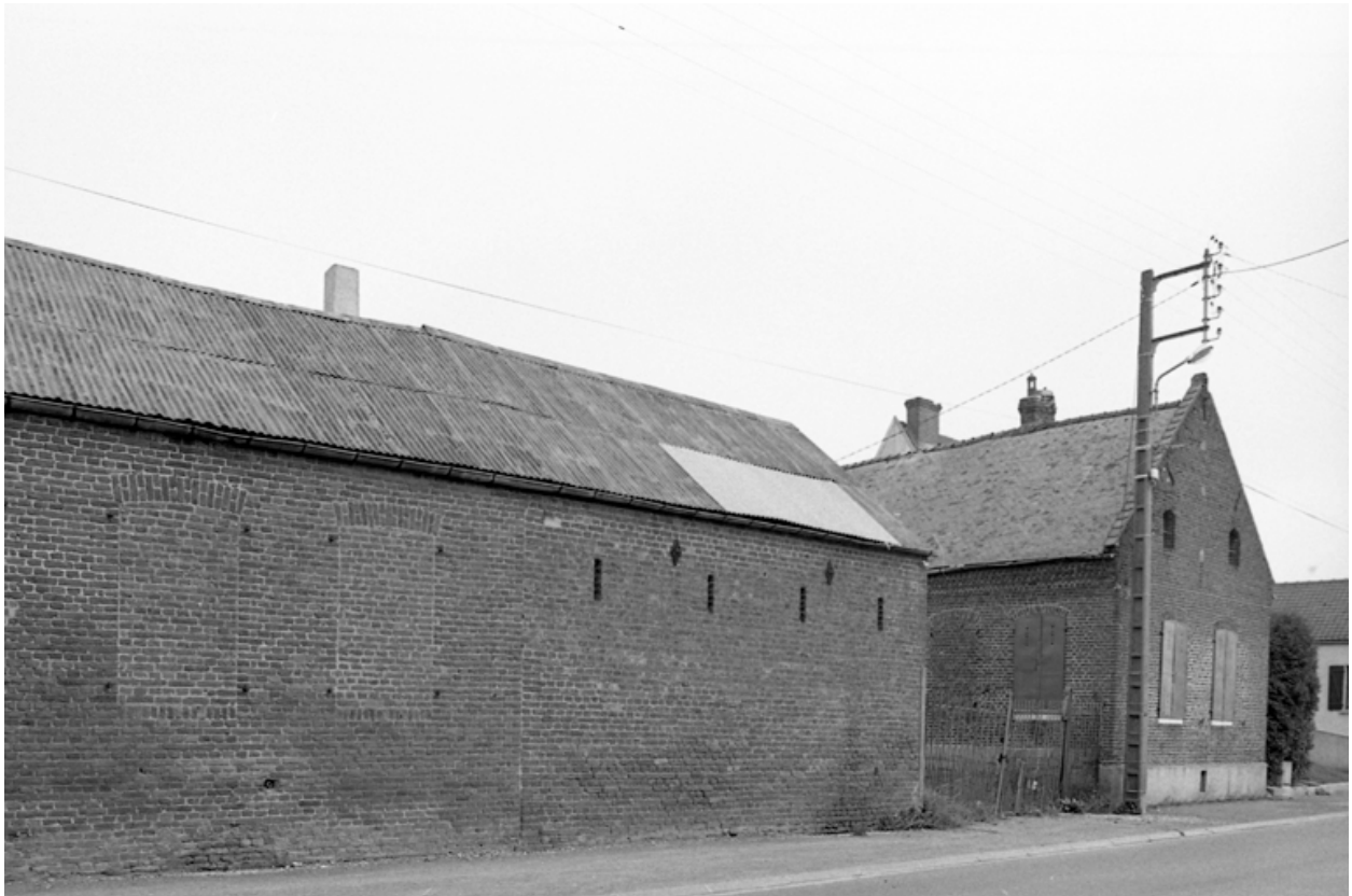
Vue d'ensemble des élévations sud-est, sur rue.
