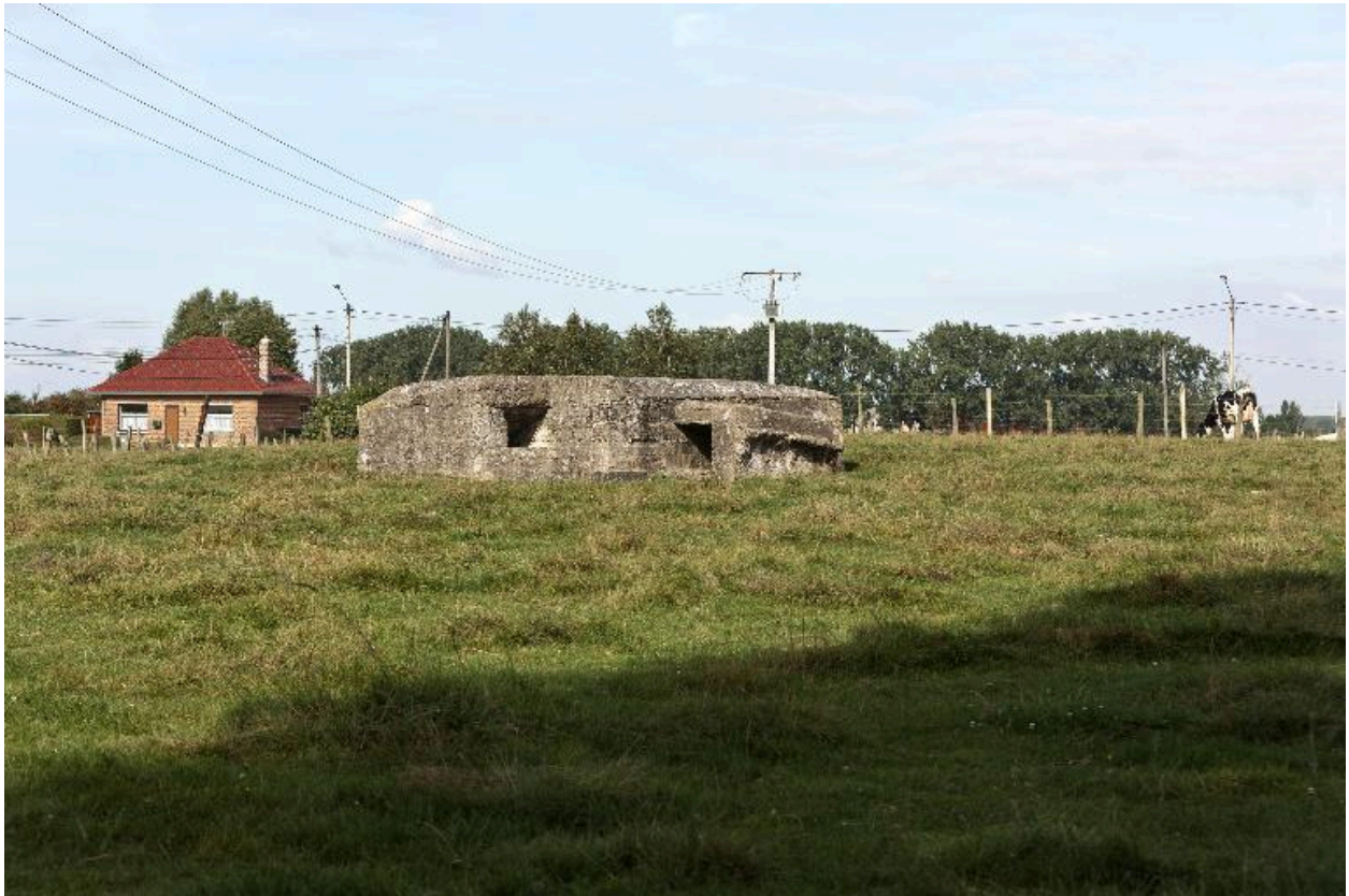
Vue générale vers le nord-ouest
