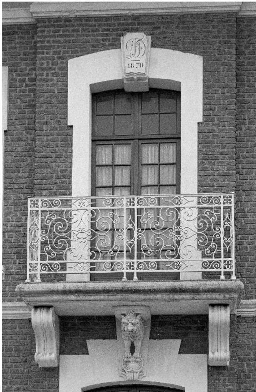
Logement patronal, élévation est : détail, en 1990.
