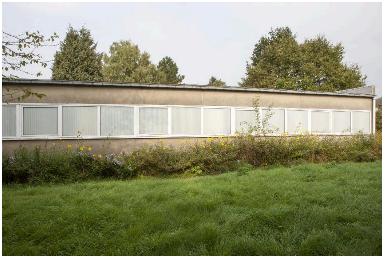
Vue des salles paroissiales à l'arrière de l'église.
