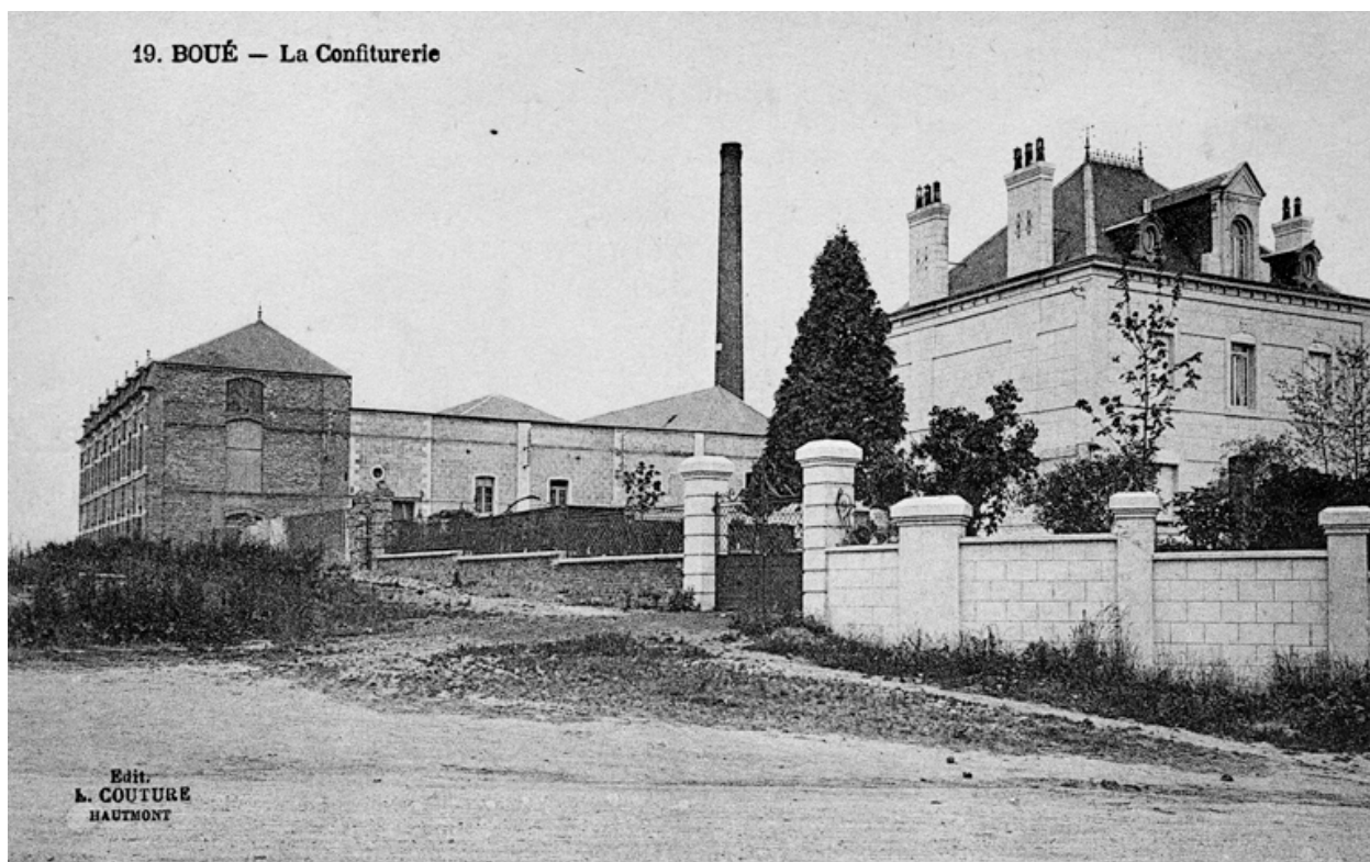
Vue générale sud-est de l'usine, vers 1930 (coll. part.).
