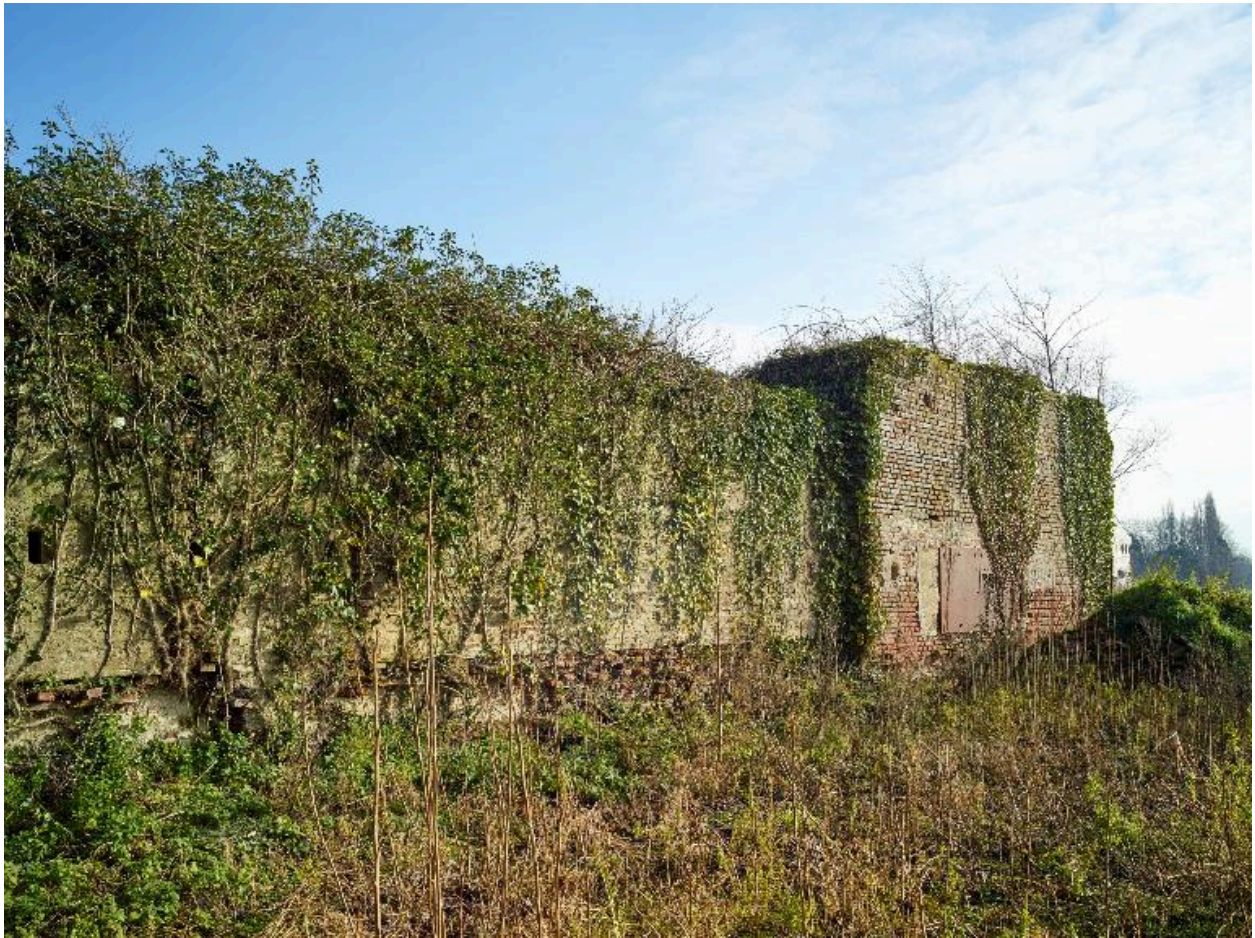
Pignon ouest de la ferme, vers le sud-est.
