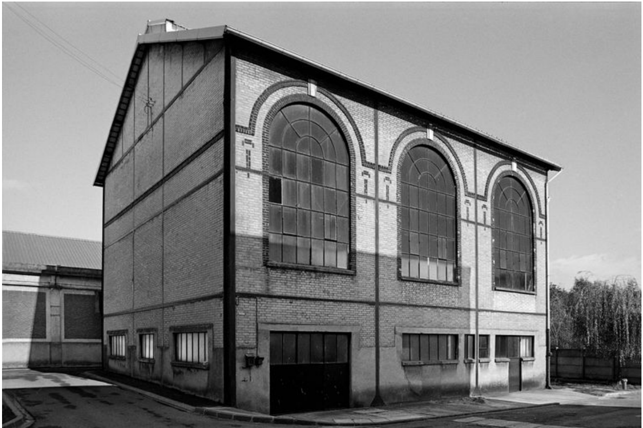
Chaufferie, flanc sud.
