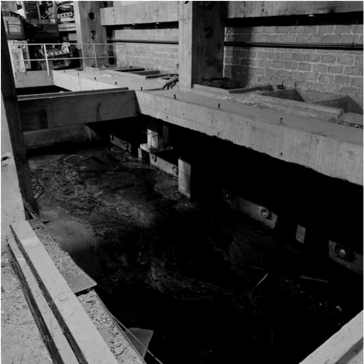
Sous-sol des bâtiments des années 1920, détail d'une fosse.
