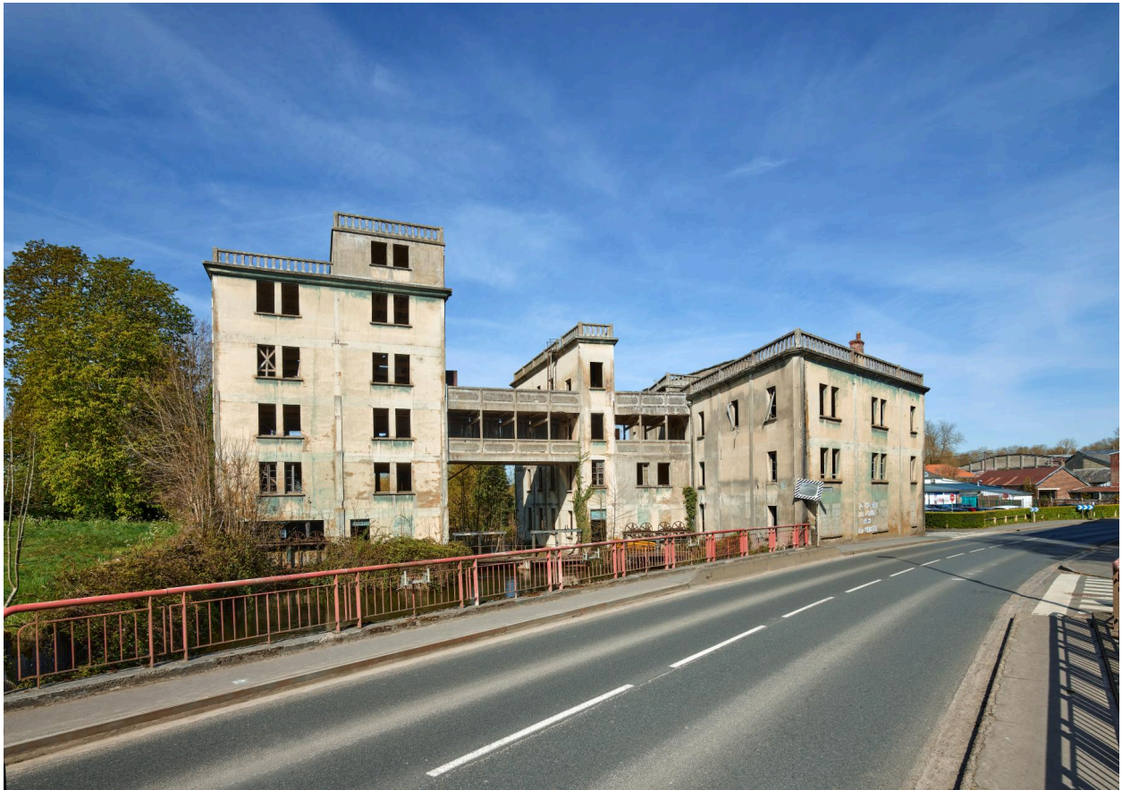
Vue générale de la minoterie du côté est, depuis le pont qui enjambe la Somme.
