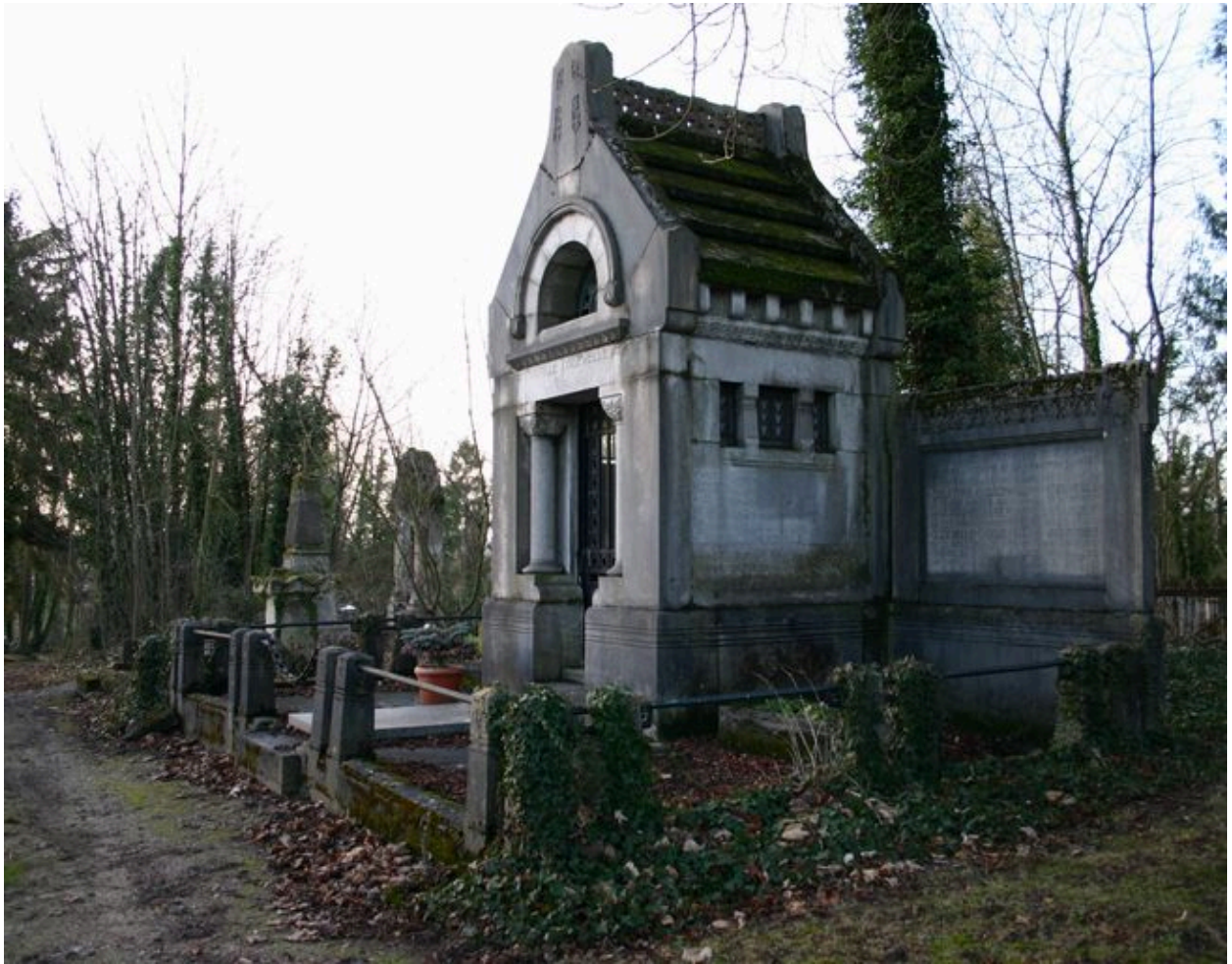
Vue générale, depuis le côté.
