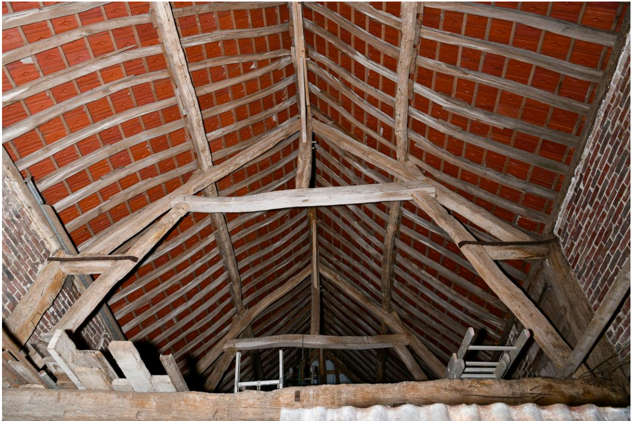
Charpente du passage charretier.
