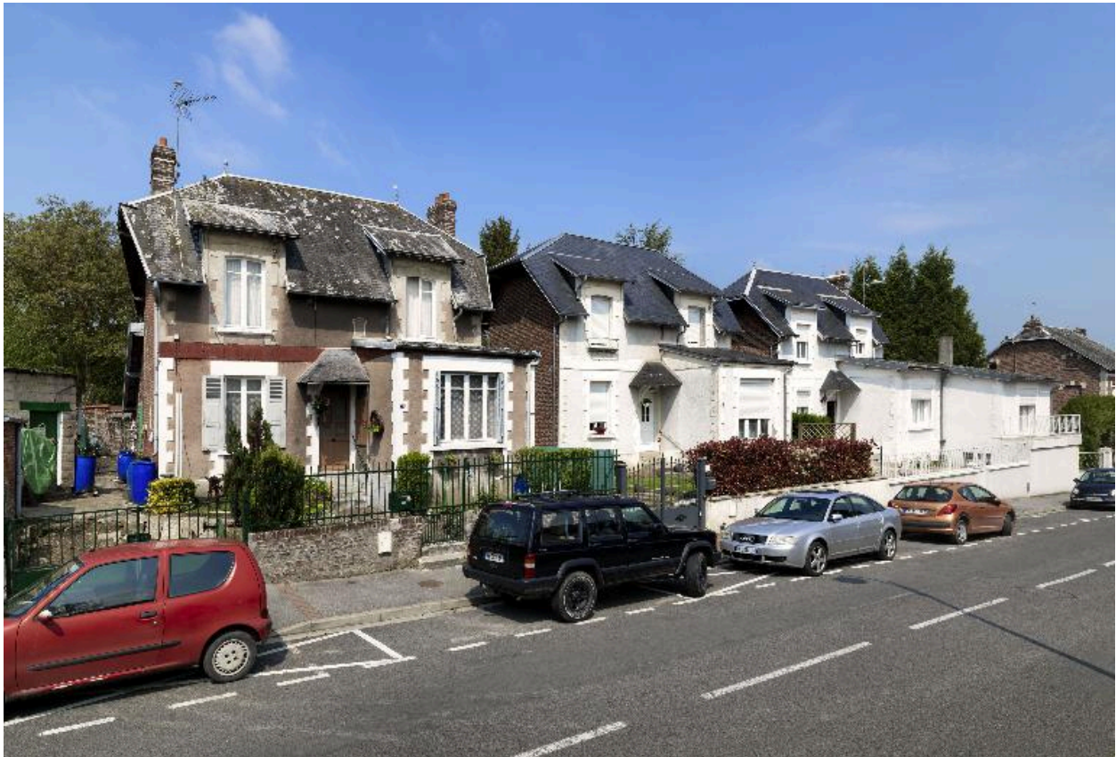
Ensemble de trois logements de contremaîtres de l'usine Maguin (74-78 rue Paul-Doumer).
