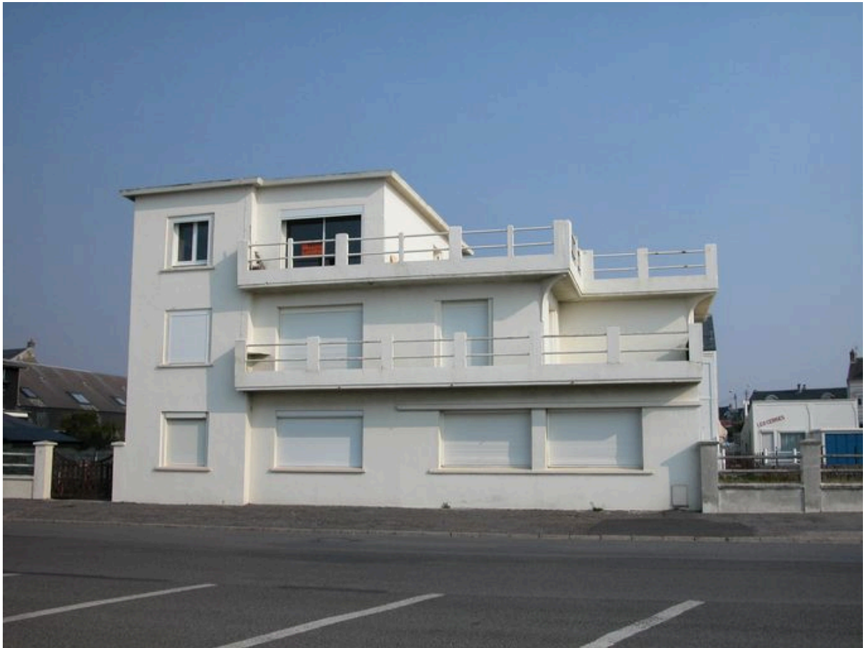
Vue d'ensemble, façade antérieure sur mer.
