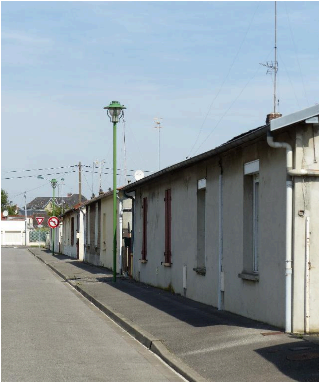
Maisons, rue d'Angleterre.
