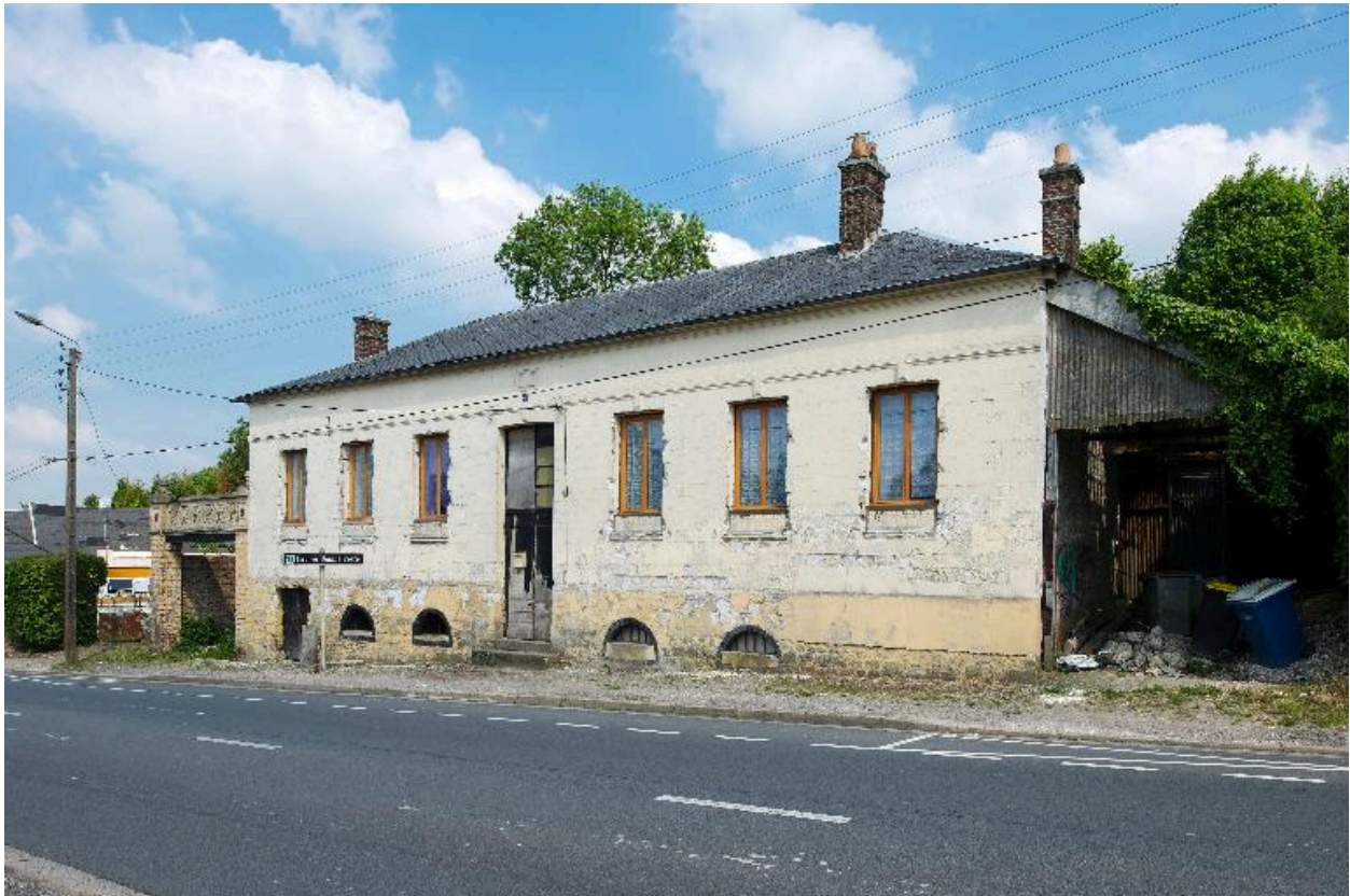
Façade sur rue, vue d'ensemble de trois-quarts.
