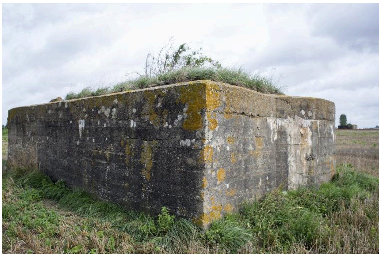
Vue de trois-quarts arrière, vers le nord
