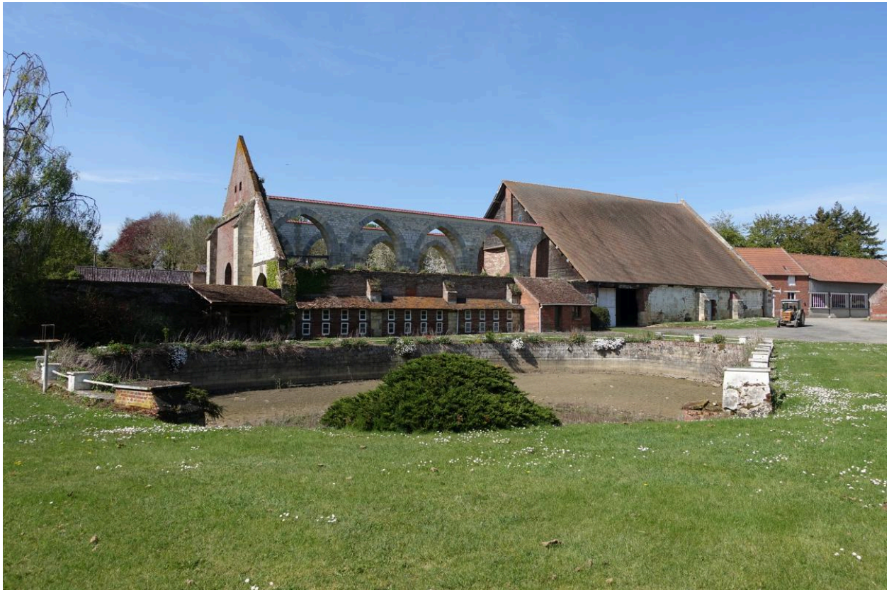
Vue générale du côté sud de la grange.
