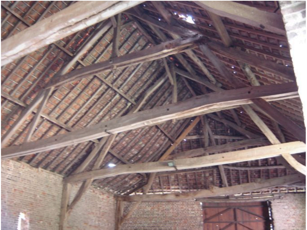
Vue de la charpente.
