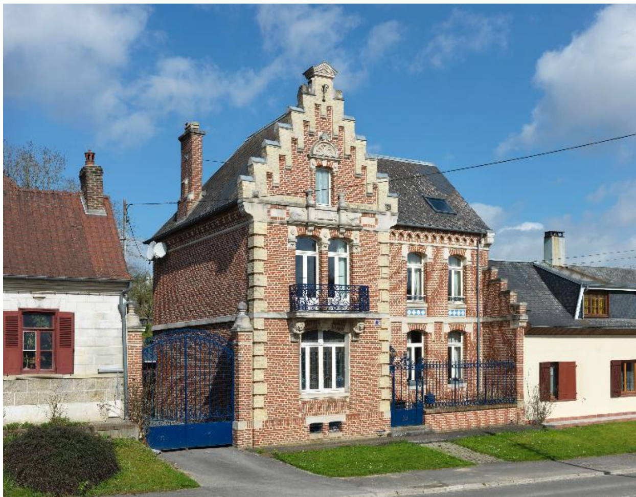
Vue d'ensemble sur rue.
