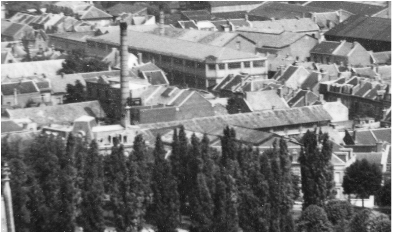
La cheminée dominant le site de la brasserie, vers 1950-1964 (AD Aisne).
