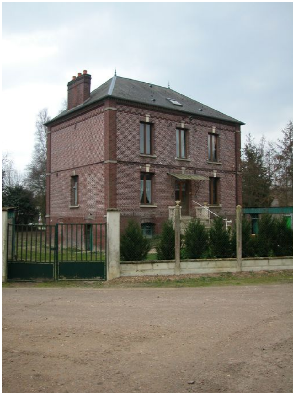
Logement patronal, ensemble postérieur.
