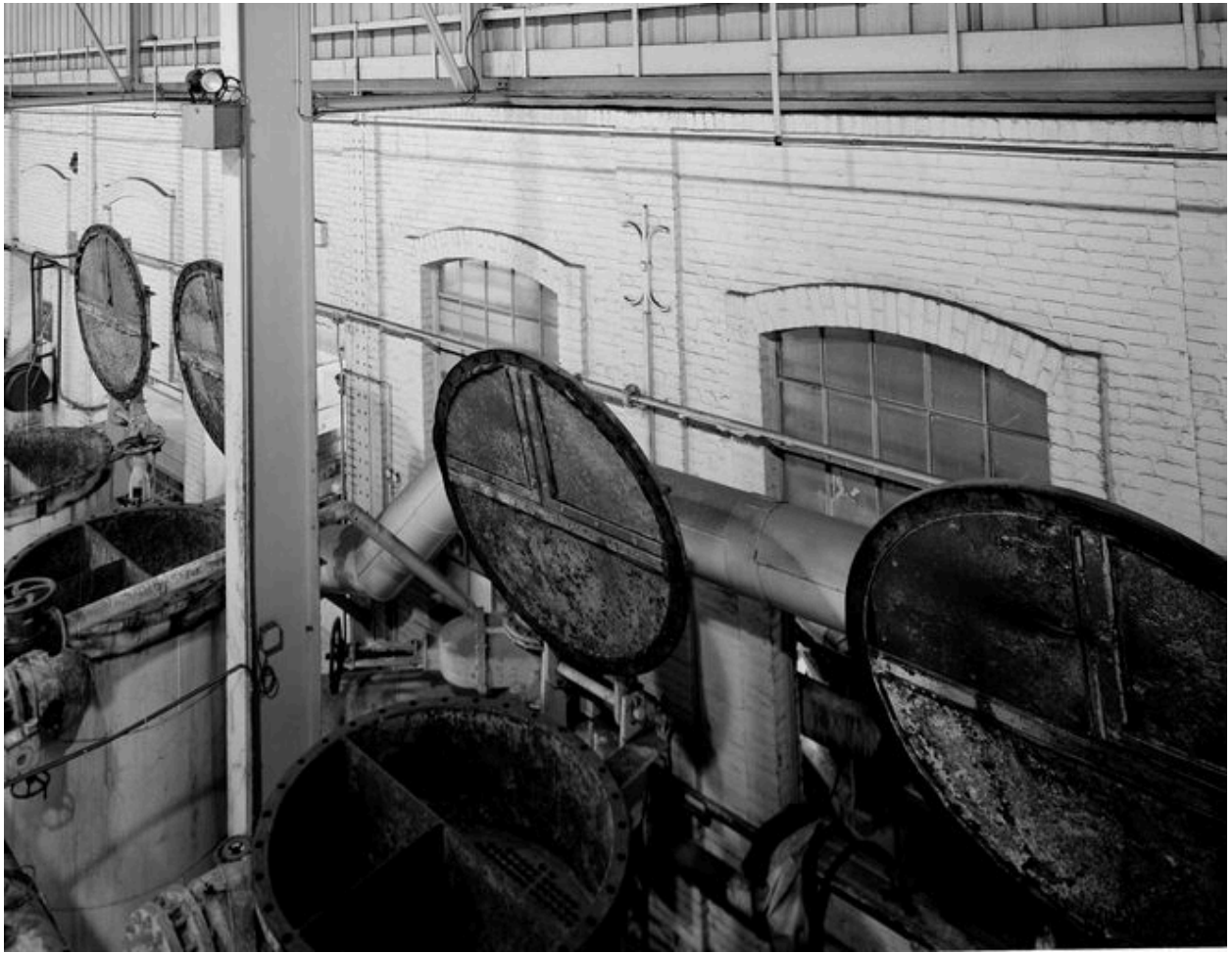
Vue intérieure de l'atelier de cristallisation, détail des cuites ouvertes.
