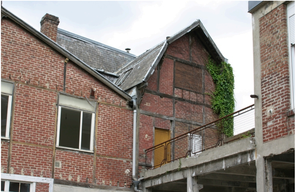
Façade antérieure des anciens magasins et ateliers : détail.
