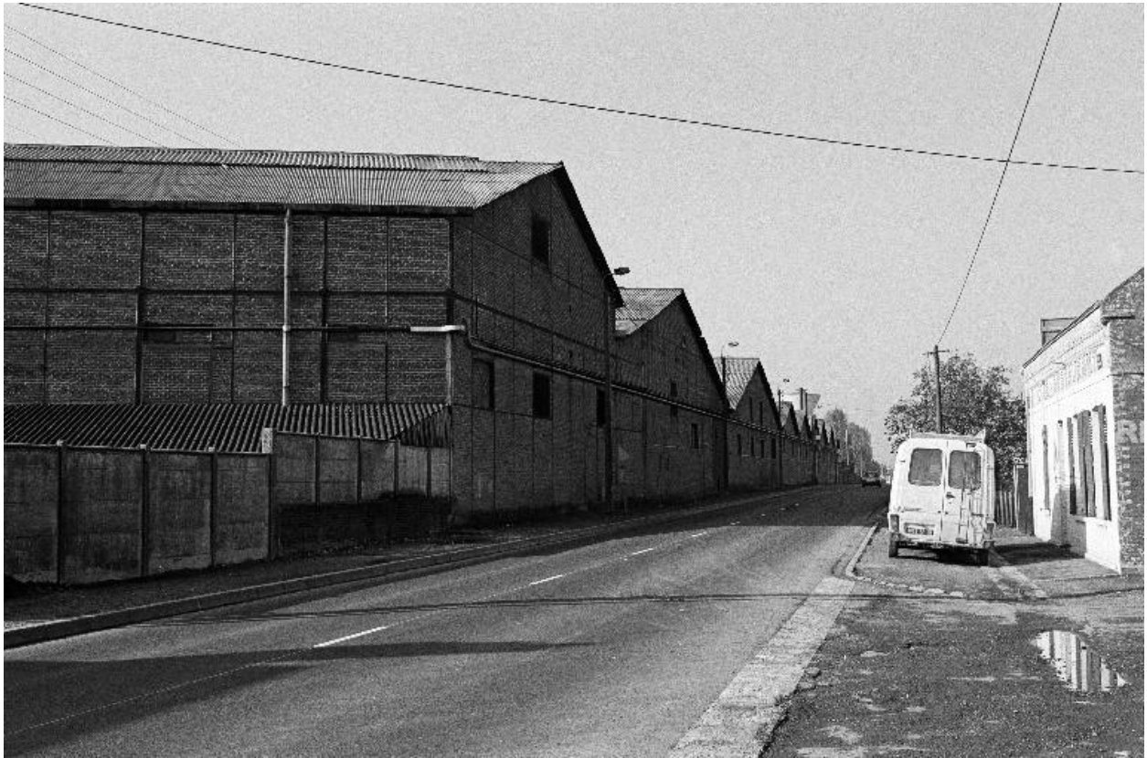
Les anciens ateliers en pan de fer et brique, vue des pignons sur rue.
