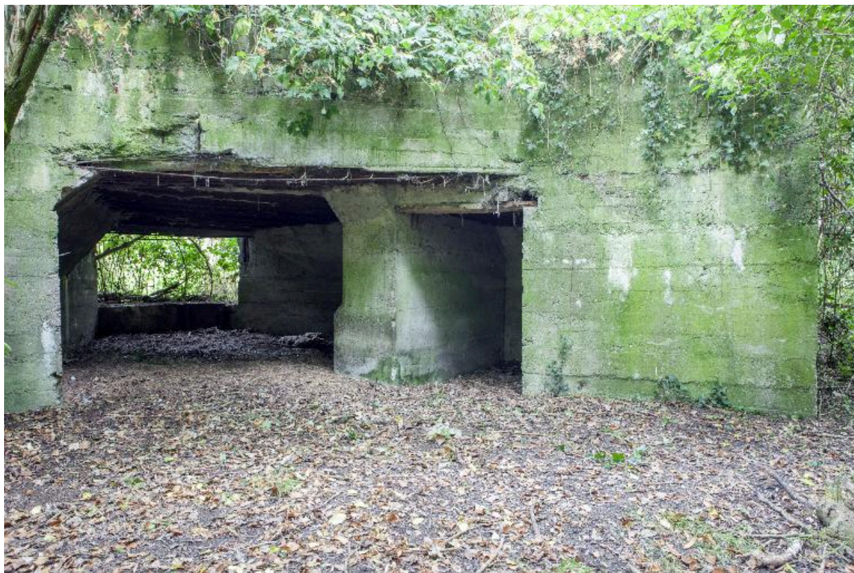
Entrée de la chambre de tir et celle de la soute à munition, à droite
