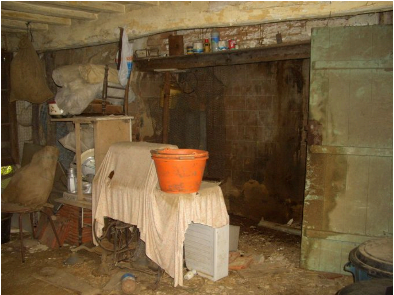
Vue de la cheminée de la salle commune.
