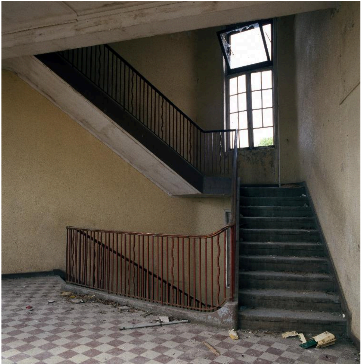
Vue de l'escalier.
