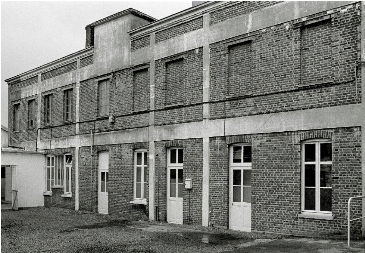
Elévation antérieure des bureaux, en 1990.
