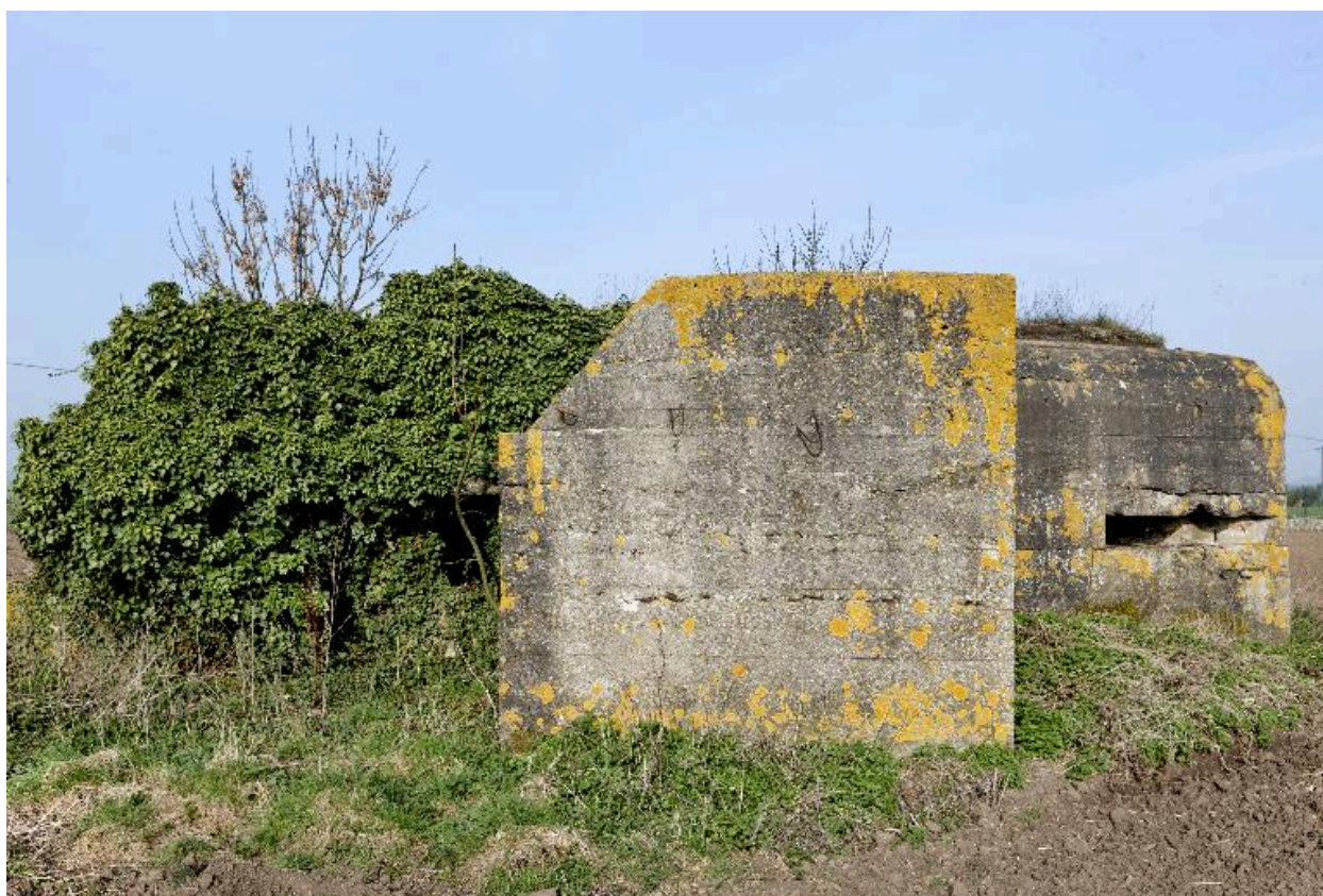
Vue latérale de la soute à munitions.
