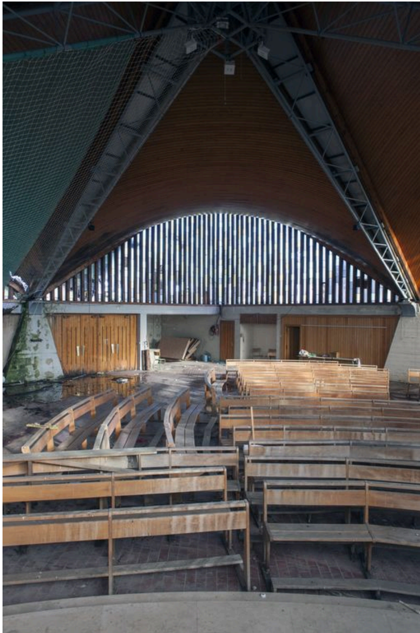
Vue générale depuis l'autel des flancs ouest et nord.
