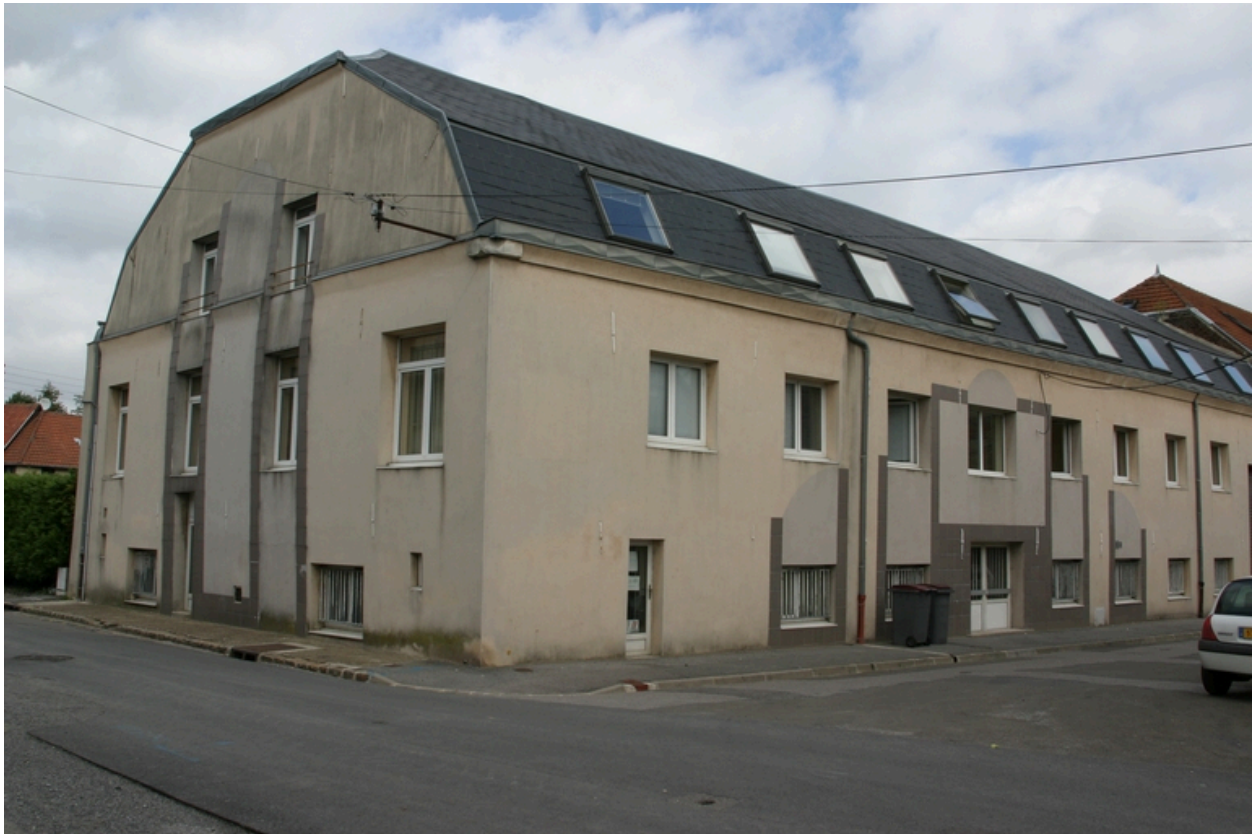
Les anciens ateliers et magasins vus depuis le carrefour des rues du Vivier et de Crimée.
