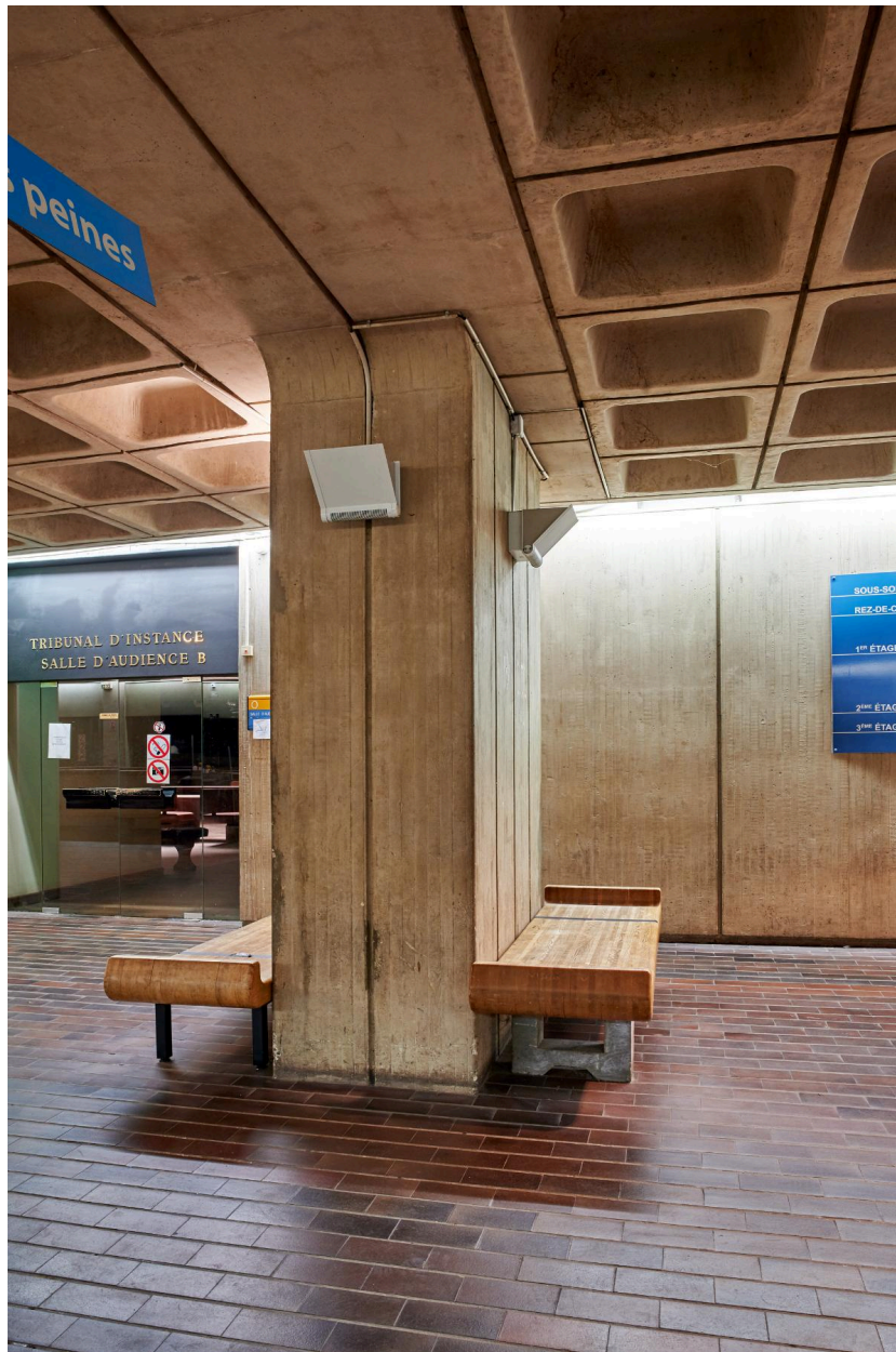
Bancs dos-à-dos avec pilier en béton servant de dossier.
