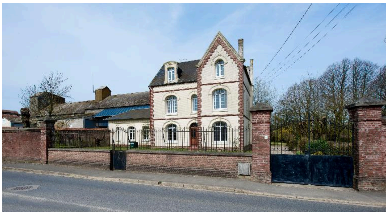
Vue générale depuis la rue Victor Hugo
