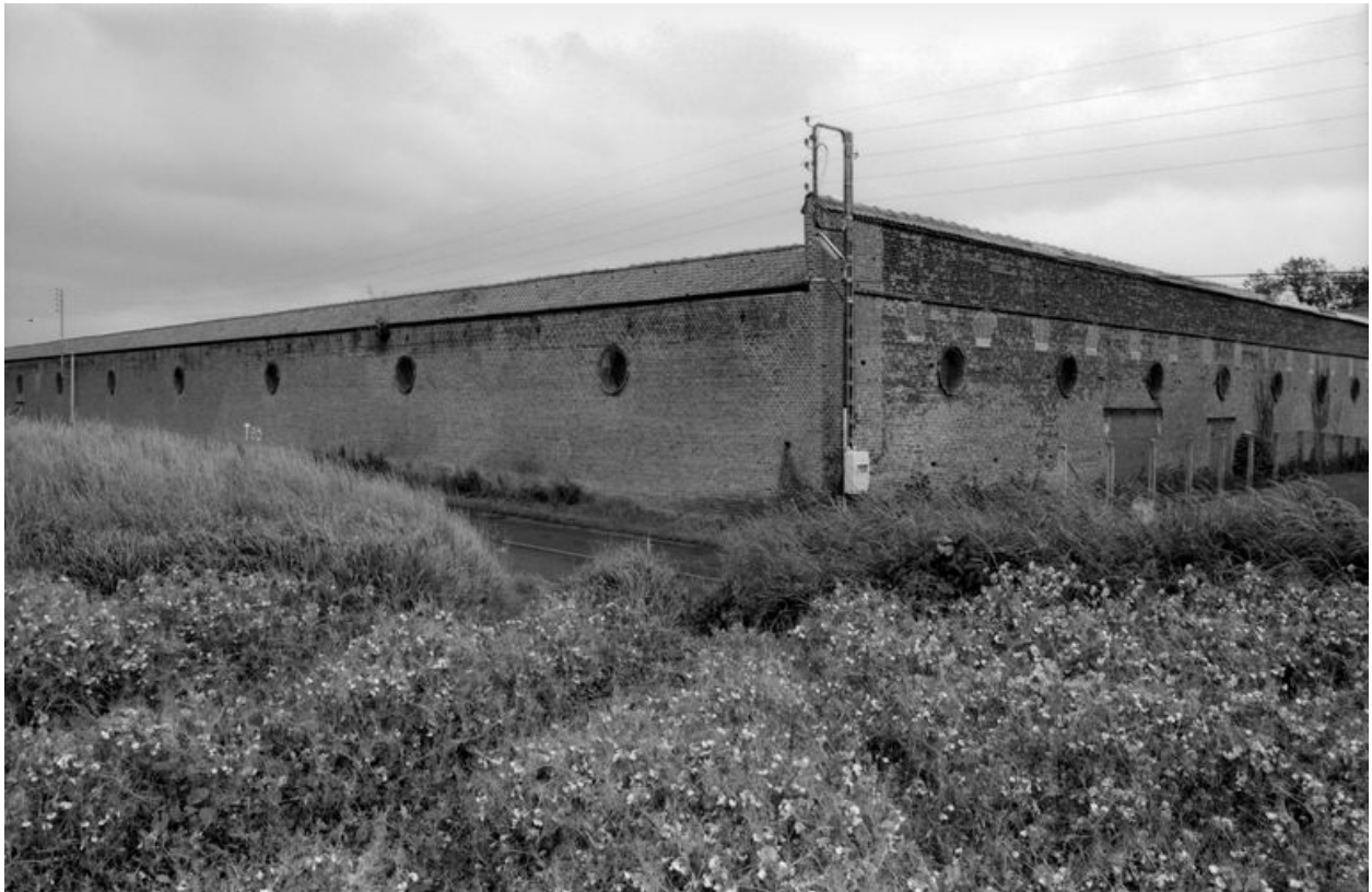
Vue partielle des ateliers de fabrication, en 1989 : flanc sud-ouest.
