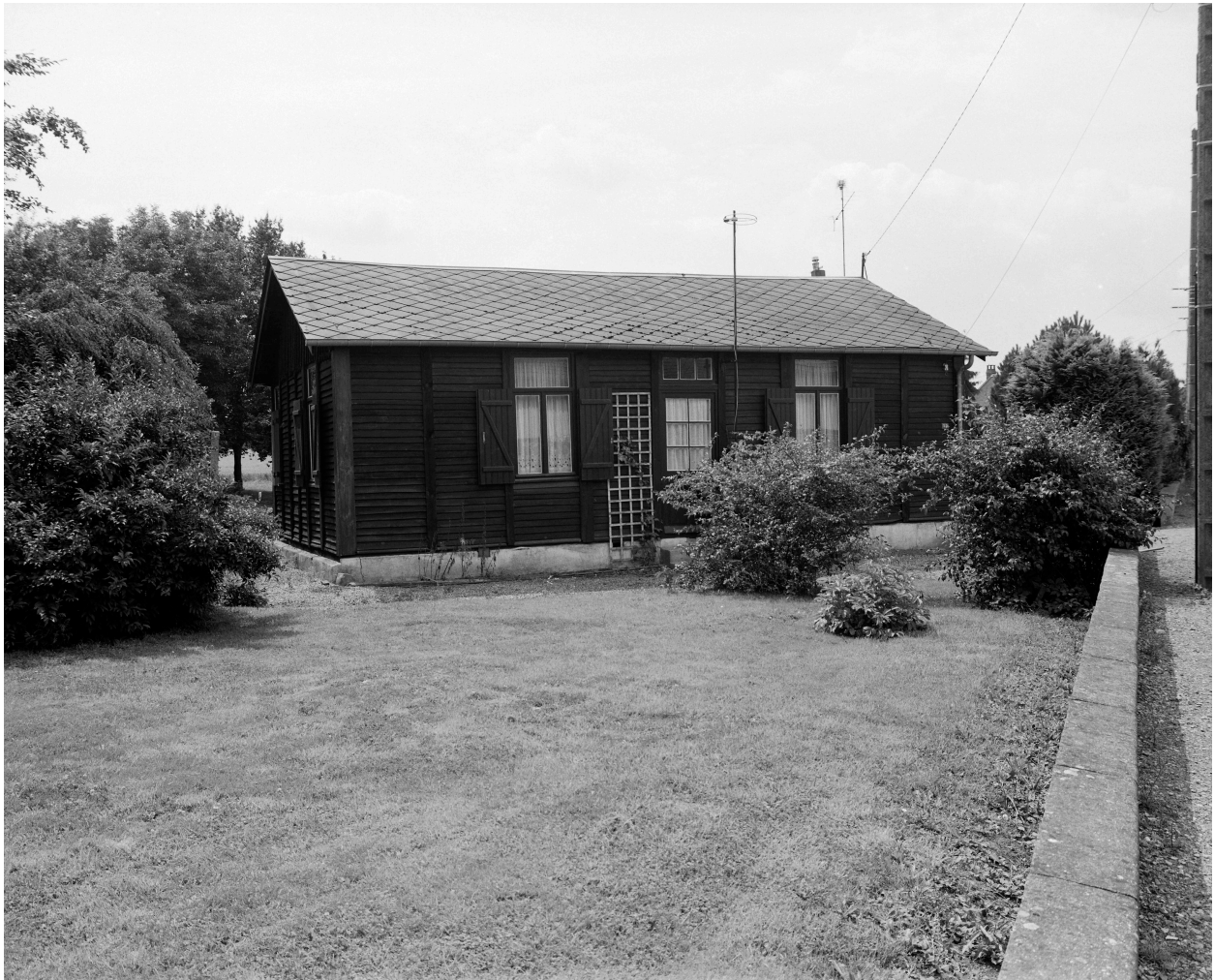
Cité de la Compagnie des chemins de fer du Nord d'Aulnoye-Aymeries. Maison en bois rue Ferrer.
