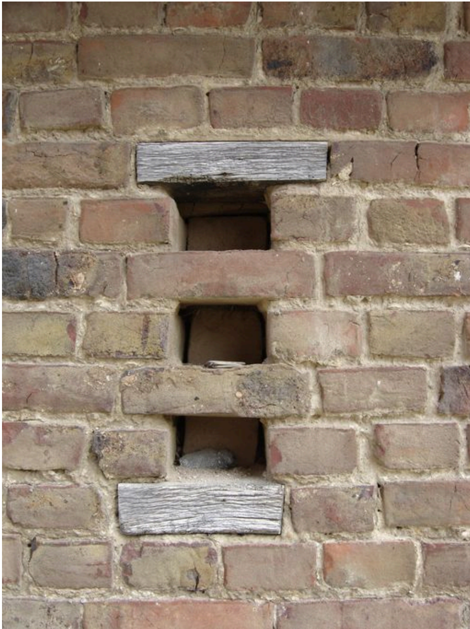
Vue des aérations sur rue.
