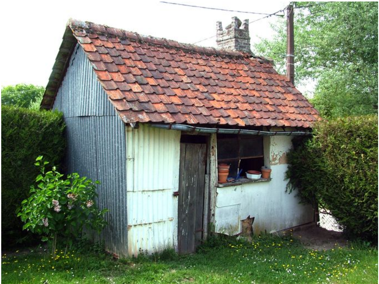
Vue du séchoir à chanvre depuis la cour.
