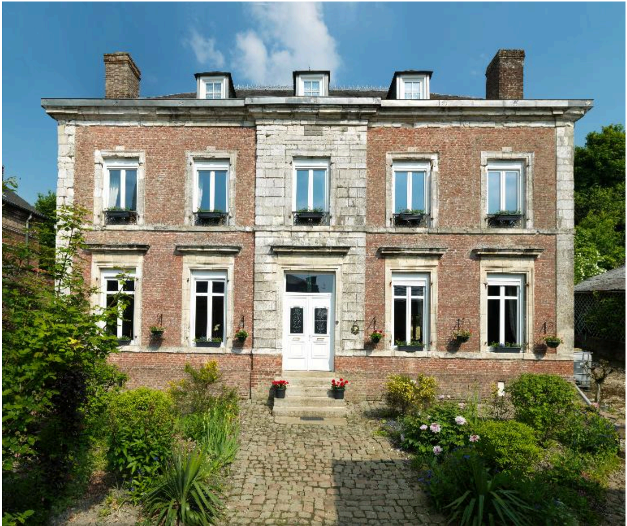
Façade sur cour.
