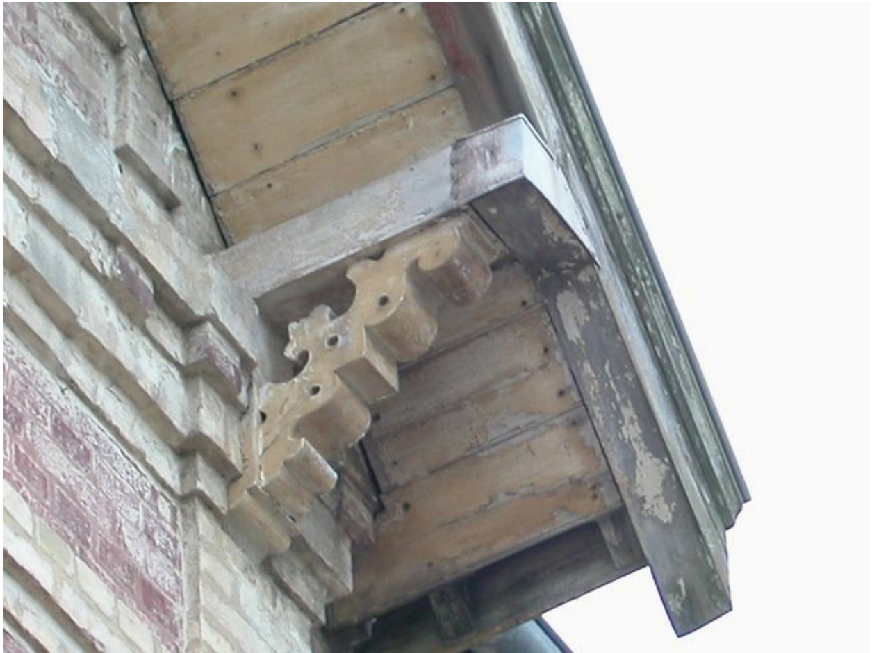
Détail d'un aisselier.
