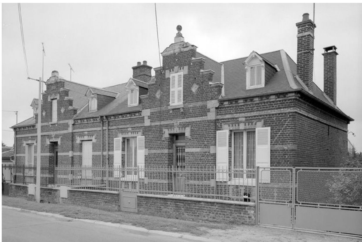
Pont-L'Évêque. Maison à deux unités d'habitation.
