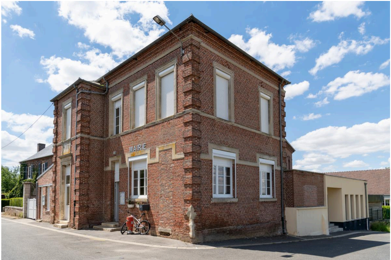
Mairie-école, rue de l'École, vue depuis le nord-est.
