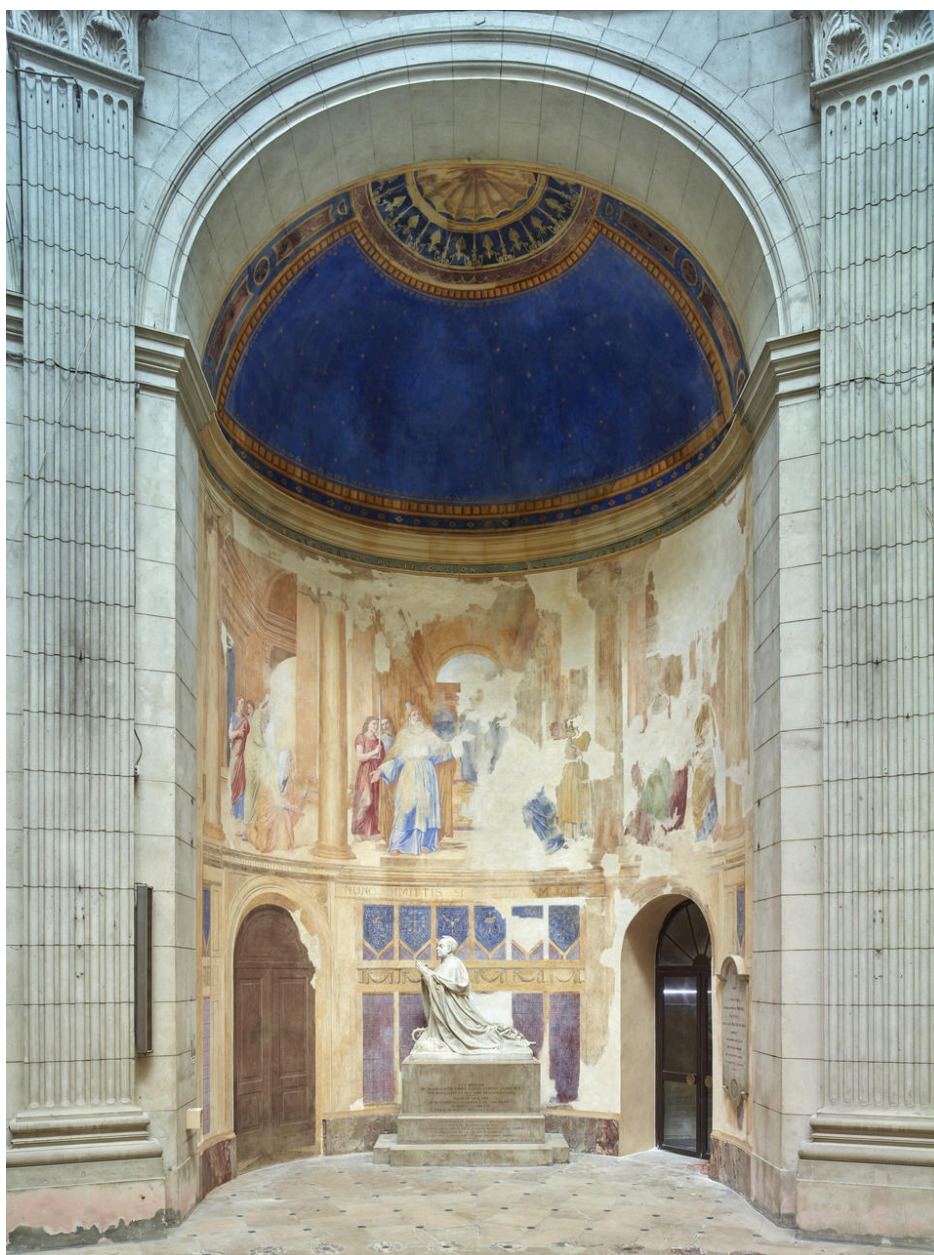
Vue générale après restauration.
