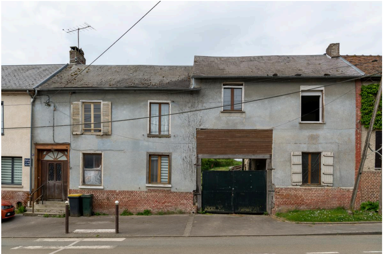
Ancien commerce, n°35 Grande Rue, vue depuis le nord-est.
